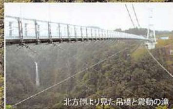
北方側より見た吊橋と震動の滝
